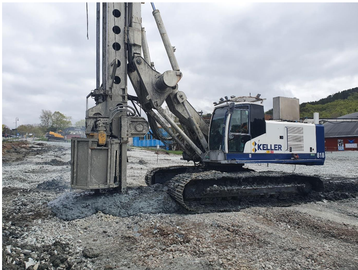
Figur 1: Eksempel på stabilisering av grunnen med KS-peler (Bilde fra Keller Geoteknikk).
