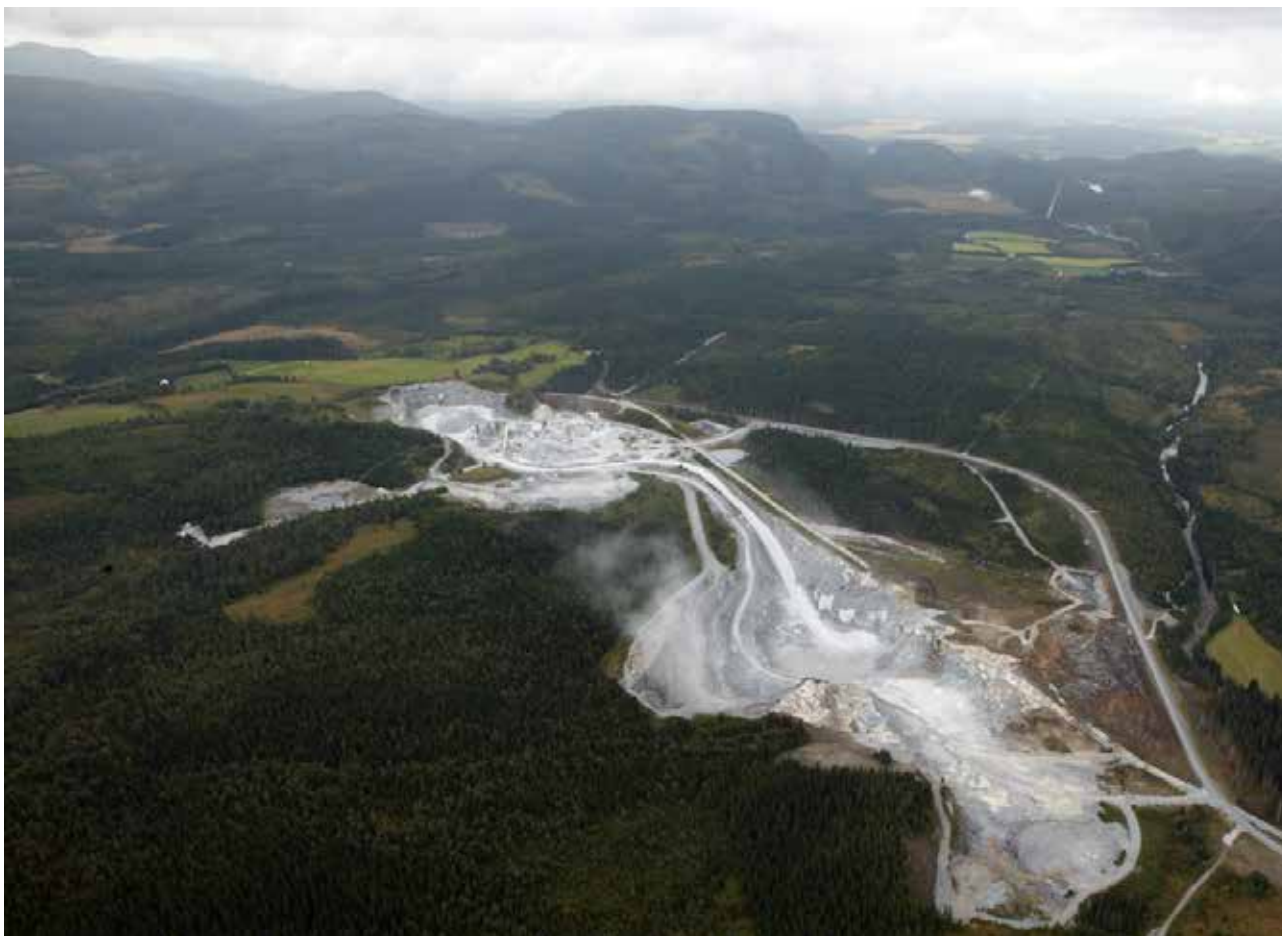
Anlegget i Tromsdalen
