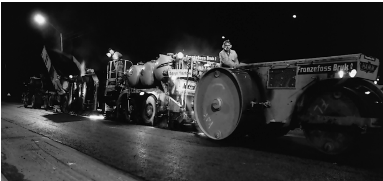
Asfaltering med Cutler, en amerikansk gjenbruksmetode vi introduserte i Norge
