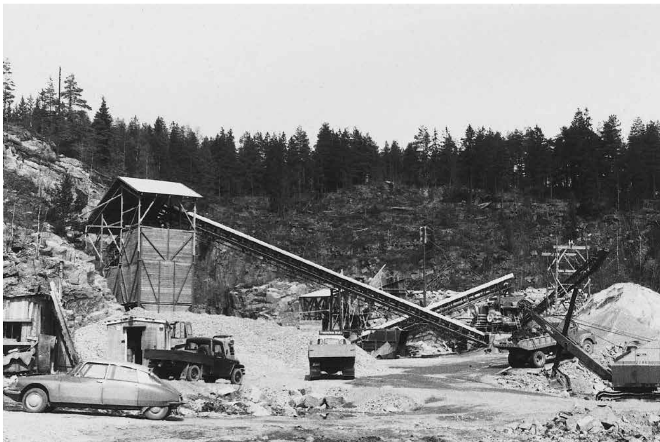
Pukkverket på Bondkall, kalt "Knusle bruk" fram til videre utbygging
