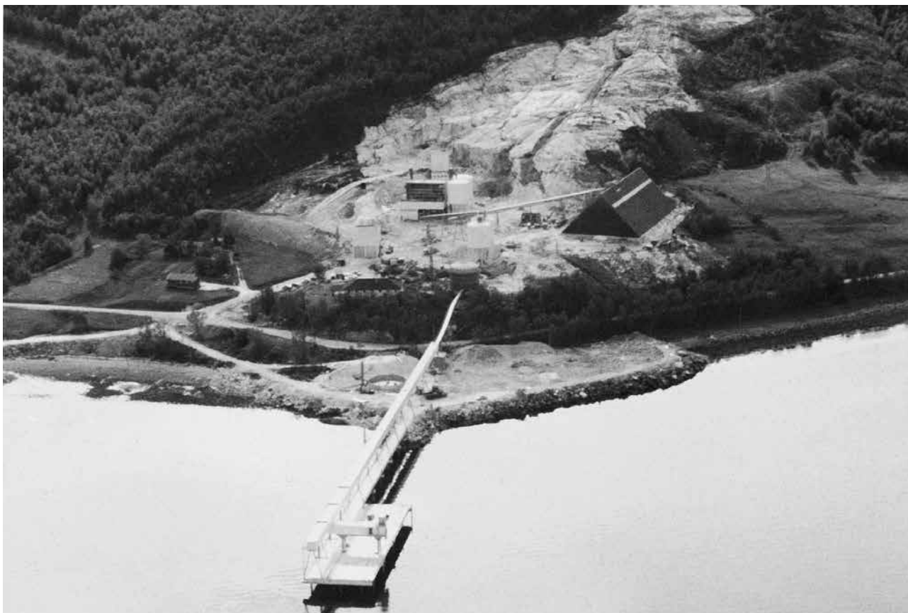
Ballangen-anlegget ferdig utbygget
