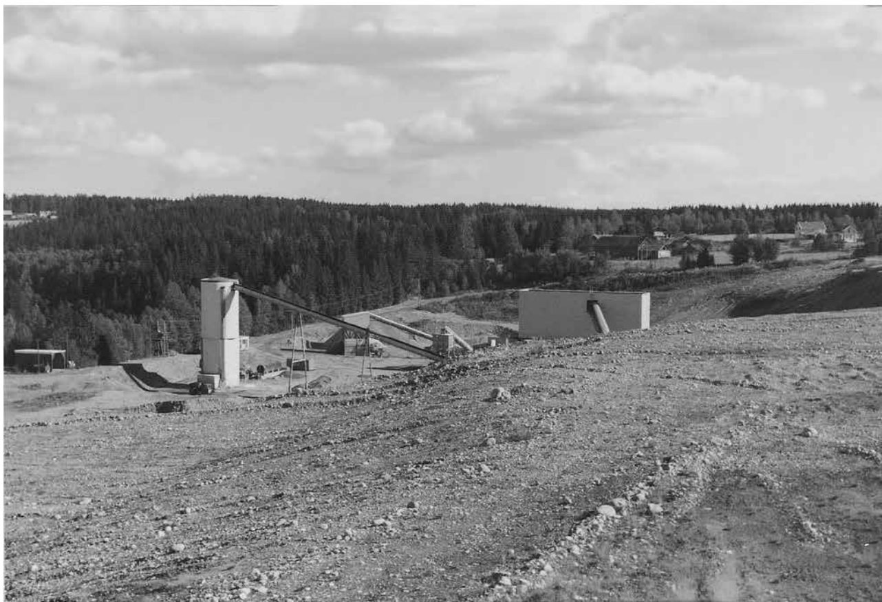
Grusanlegg med betongfabrikk på Villberg
