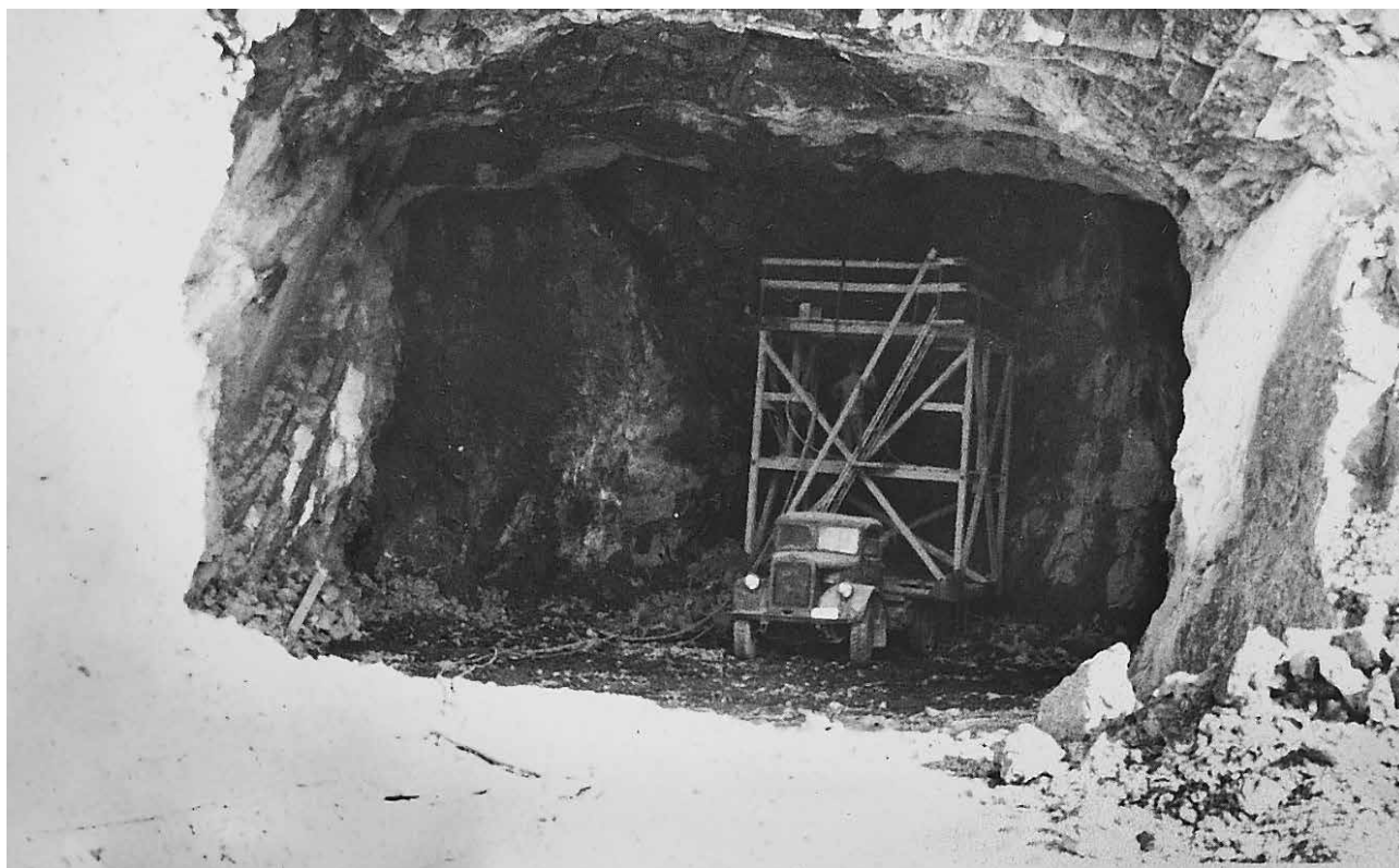
Påhugg A-tunnelen, knematerboring fra plattform på kanonlavett
