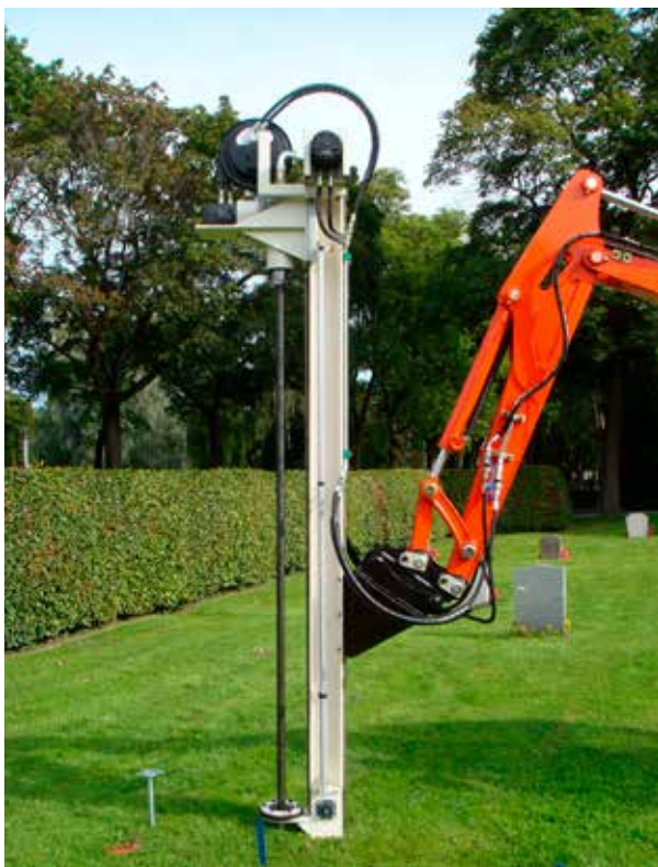
Norsk Miljøstabiliserings (NOMIAS) kalkbehandling av graver
