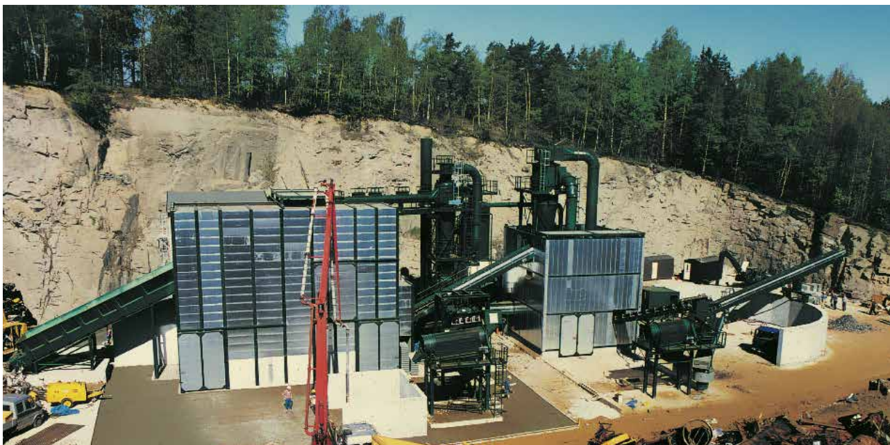
Nytt shredderanlegg ble bygget i Fredrikstad i 1998
