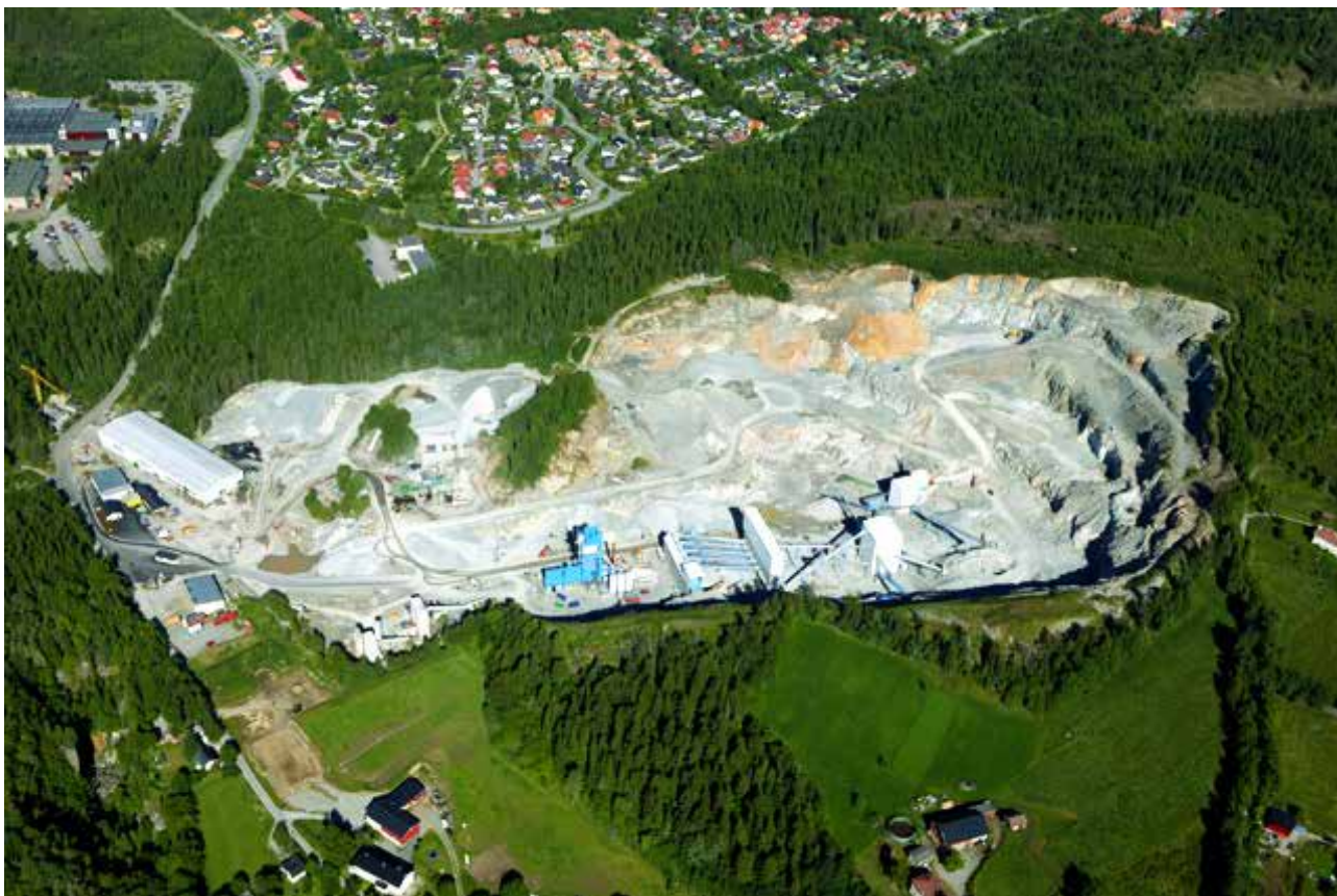
Det nye pukkverket på Lierskogen
